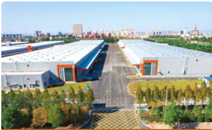
丰树(灵寿)综合供应链产业园
