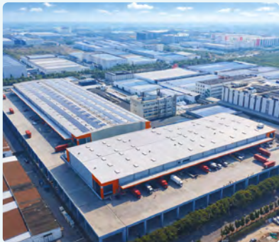
丰树(苏州)现代服务智慧产业园已经获得LEED O+M: 既有建筑金级认证
