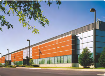
2019年收购位于美国弗吉尼亚州阿什本市的44490 Chilum Place,该项目是一座超大规模数据中心,配备完善的基础设施。
