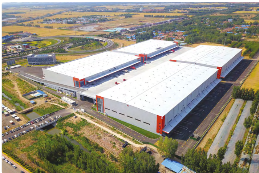
丰树(齐河)国际综合产业园是丰树2025/26财年在中国竣工的六座物流园之一。
