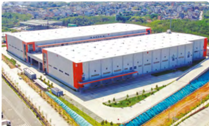
丰树揭东现代物流综合产业园
