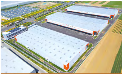
丰树唐山现代供应链产业园
