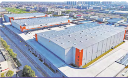
丰树(启东)综合产业园项目
