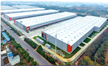
丰树(江阴)综合产业园区
