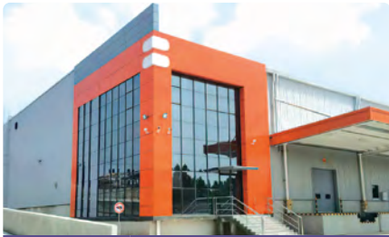
丰树(洛阳)现代综合物流园
