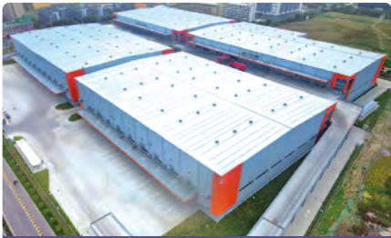
丰树(姚庄)科技综合产业园
