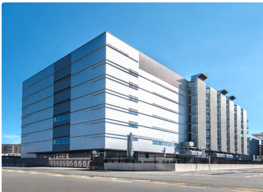
2025年5月，丰树工业信托完成了位于日本的大阪数据中心的最后一期装修工程。
