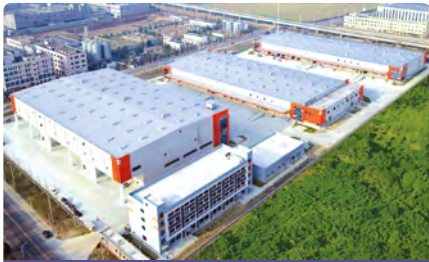
丰树成都中央厨房产业园
