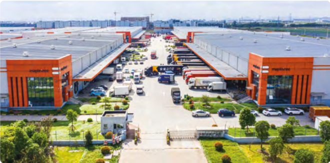
丰树(余姚)产业园于2019年竣工,由四座单层仓库组成,地处中国浙江省,毗邻宁波人口密集区及核心交通枢纽,区位优势显著。
