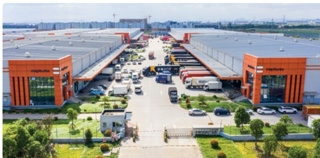
2019年に竣工したMapletree (Yuyao) Logistics Parkは、4棟の平屋建て倉庫で構成されており、中国・浙江省の寧波市の人口密集地や主要な交通ハブの近くに戦略的に立地しています。
